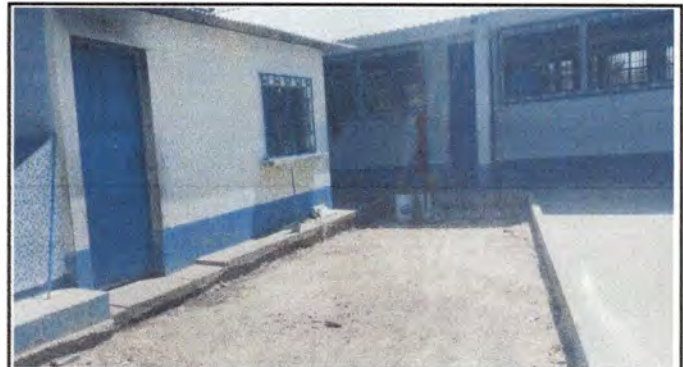
Foto 4: Vista de área para sustitución de suelo natural a piso losa de concreto.
