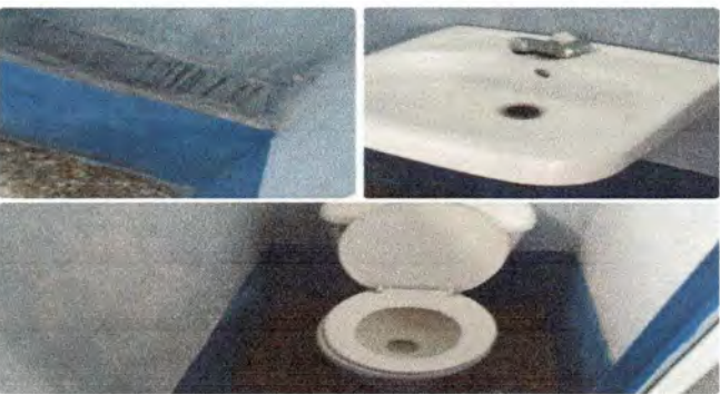
Foto 3: vista de áreas de sanitario a reparar y renovar.
