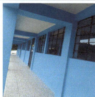
Foto 4: Instalación de balcones de metal.
