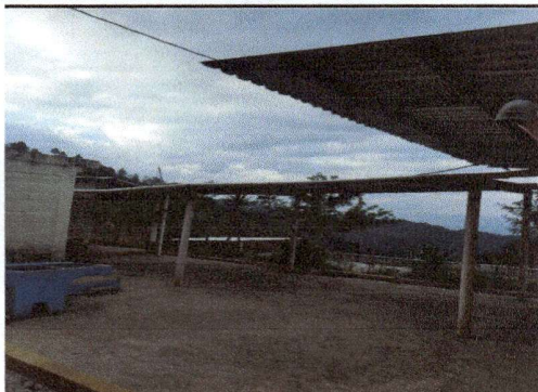
Foto1: Sustrución de lámina mal estado
