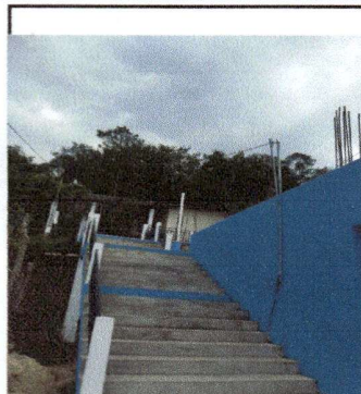
Foto 2: Techado en área de gradas como mantenimiento preventivo.
