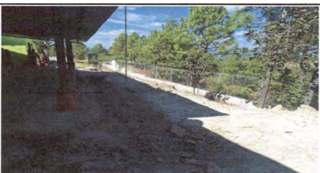
Foto 11: Vista del patio antes del adoquinamiento vista al frente modulo II.
