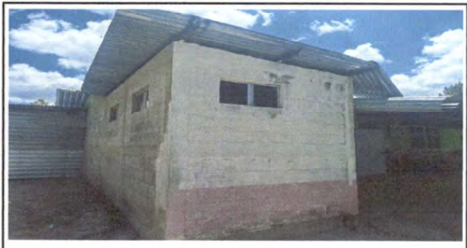
Foto 4: Antes de la colocación de volcones de baños lateral.
