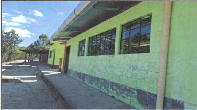
Foto 1: Antes de la colocación de volcones Modulo I parte frontal.
