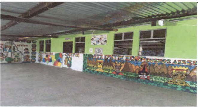
Foto 5: Antes de la colocación de volcones Modulo II parte frontal.
