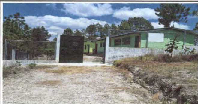
Foto 7: Antes de colocación de techo para el portón de la entrada principal.
