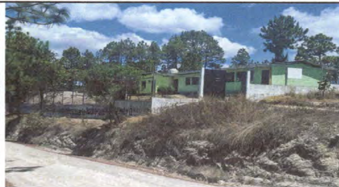
Foto 8: Antes de colocación de techo para el portón de la entrada principal.
