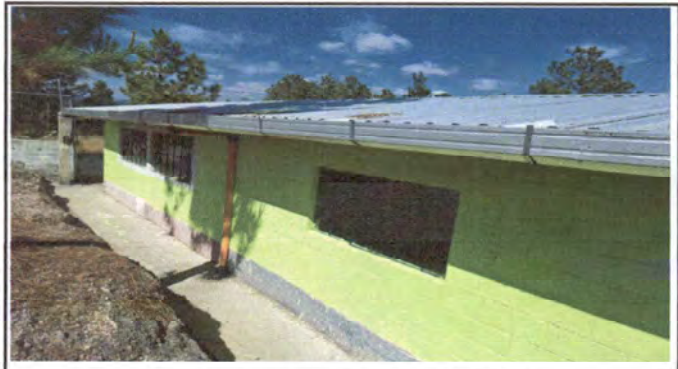
Foto 2: Antes de la colocación de volcones Modulo I parte trasera.
