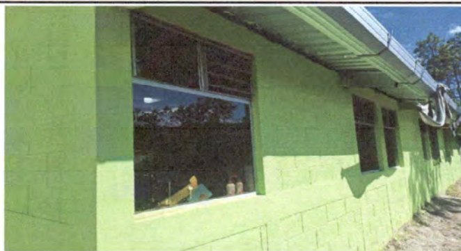
Foto 3: Antes de la colocación de volcones Modulo II parte trasera.
