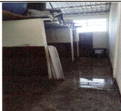
Foto 2: Módulo de baños de la escuela, donde se estará realizando la remodelación.
