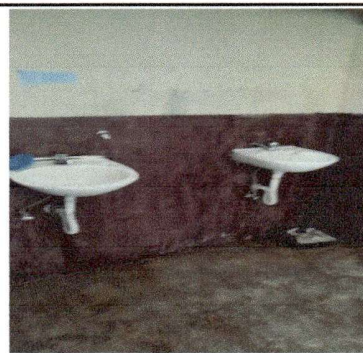
Foto 6: Lavamanos que serán cambiados.
