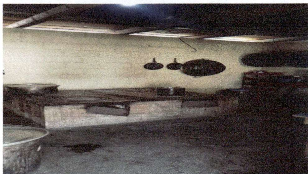
Foto 1: En la fotografía se puede visualizar el estado actual de la cocina, mismo lugar donde se realizará el remozamiento.
