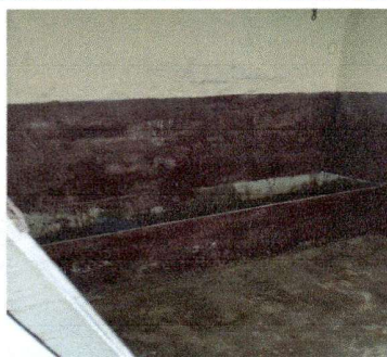
Foto 3: Espacio del baño donde se estará implementando baños para el nivel preprimario.
