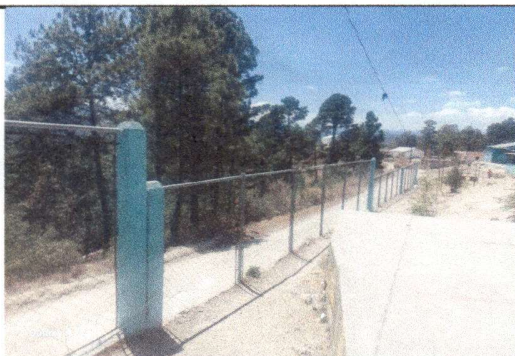
Foto 5: remozamiento de pared circulación en la parte frontal del establecimiento
