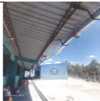
Foto 6: sustrucción de canal PVC mas bajada de agua
