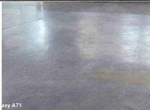
Foto 3: sustrucción de piso tipo cemento alisado por piso granito
