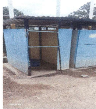
Foto 2: cambio de puertas y pared en mal estado
