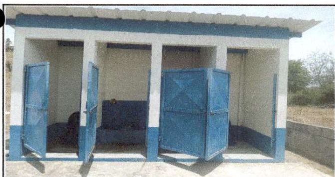
Foto 5: Sustrucción de baños de poza séptica a baños lavables.
