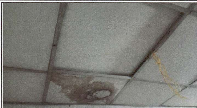
Foto 2: Reparación de estructura de techo con la instalación de cielo falso con tablayeso para un aula con estructura de metal.
