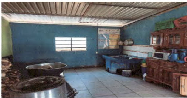
Foto 9: colocacion de azulejo en pila de concreto, adhesivo MP4, siza
