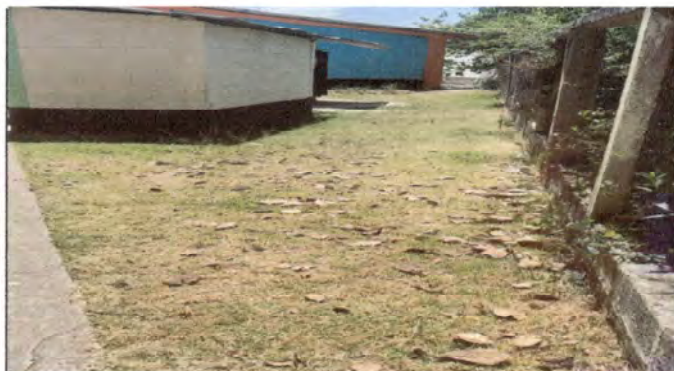
Foto 4: reparación de patio y muro perimetral
