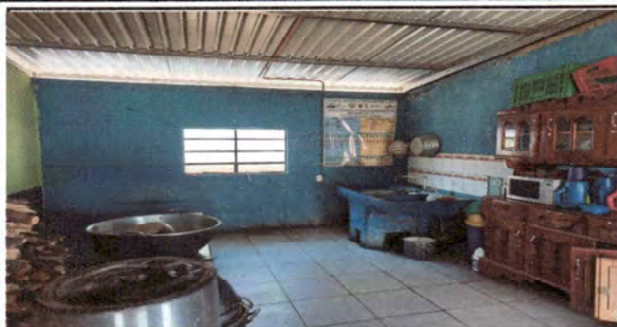
Foto7: sustitucion de azulejo de cocina
