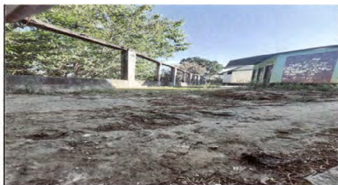
Foto 3: reparación de patio
