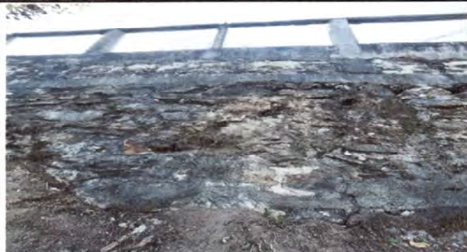
Foto1: reparación de muro perimetral.
