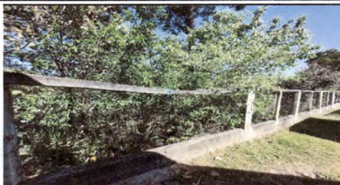
Foto 2: reaparacion de muro perimetral .
