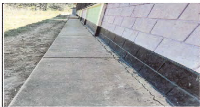
Foto 5: Reparación de banqueta de cemento
