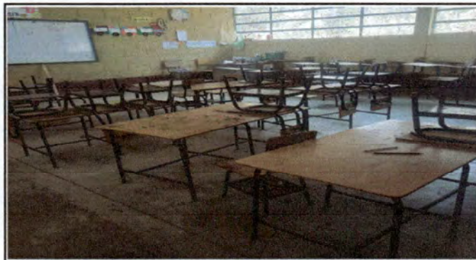
Foto 2: Aula 2, para instalación de piso cerámico
