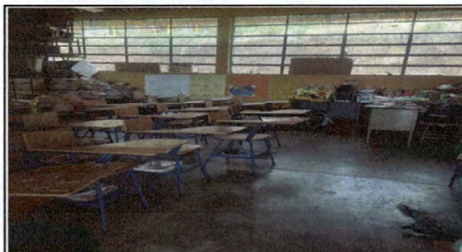
Foto 3: Aula 3, para instalación de pisos
