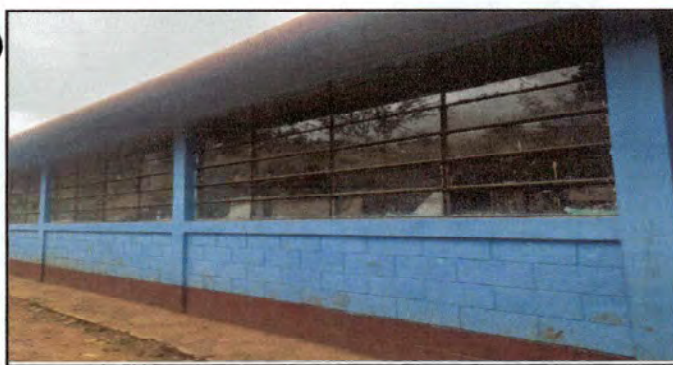
Foto 5: Aulas para instalación de balcones ( parte de atrás 3 aulas)
