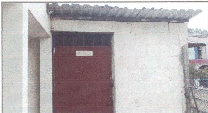
Foto 2: Reparación de bodega
