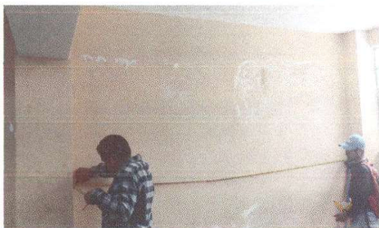
Foto 9: Reparación de repello en mal estado
