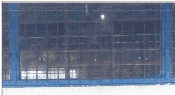
Foto 6: Sustitución de vidrios
