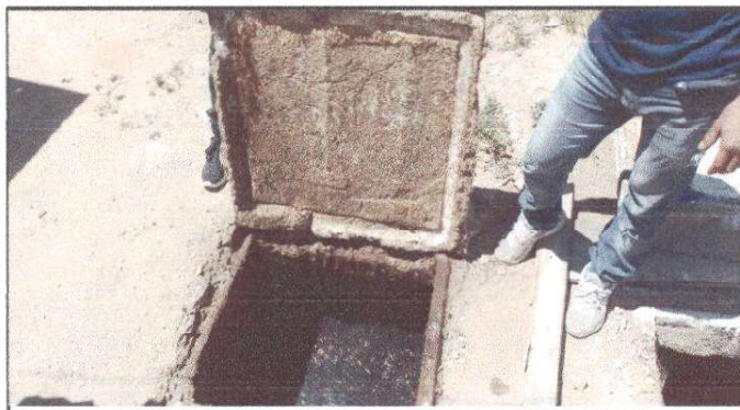
Foto 4: Mantenimiento de fosa septica
