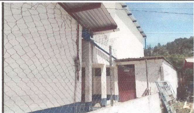
Foto 7: Sustrucción de malla muro perimetral
