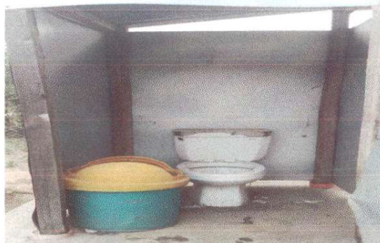
Foto 3: Reparación de servicio sanitario
