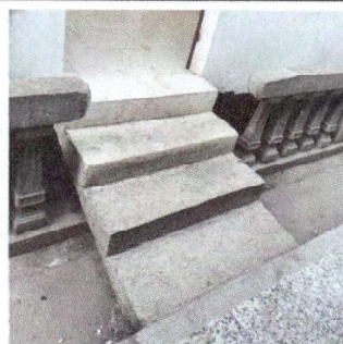
Foto 6: Instalación de barandas en bodega y dirección.
