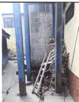
Foto 4: Instalación de puerta corrediza
