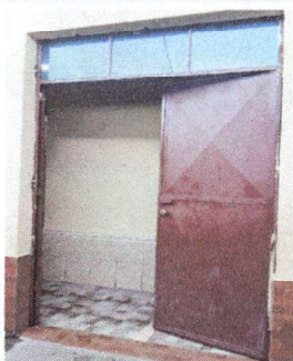
Foto 5: Mantenimiento a estructura lijado y aplicación de pintura en 9 puertas en servicios sanitarios.
