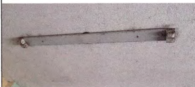
Remozamiento de plafoneras por candelas EN AULA DE PROFESORES DE 1ER NIVEL
