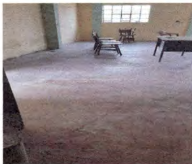
Sustitución de piso cemento por piso cerámico EN AULA DE PROFESORES DE 1ER NIVEL
