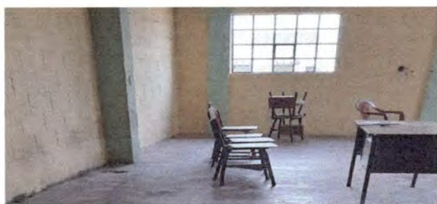
Remozamiento de pintura del establecimiento EN AULA DE PROFESORES DE 1ER NIVEL
