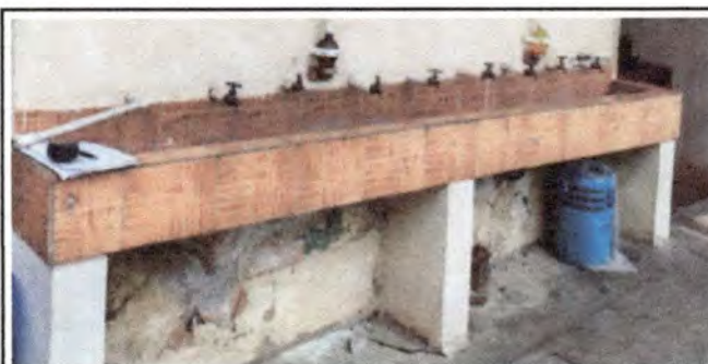
Remozamiento de chorros de lava manos
