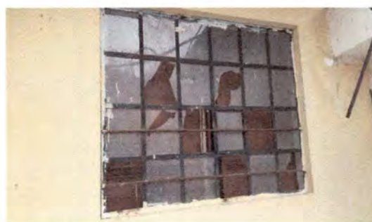
Reparación de Vidrios EN AULA DE PROFESORES DE 1ER NIVEL
