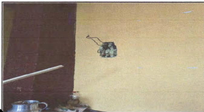
Reparación eléctrica en cocina
