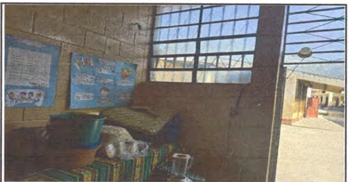
Reparación eléctrica en cocina
