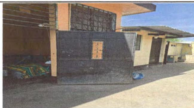
Mantenimiento de puerta y cambio de chapa
