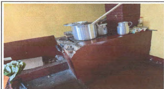
Reparación de plancha de cocina
