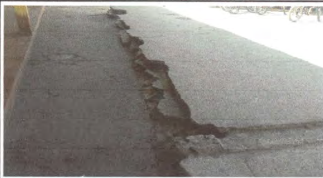
Sustitución de piso de concreto de 5 centímetros de espesor para nivelación en el patio
