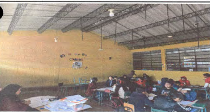
Reparación eléctrica en aula
