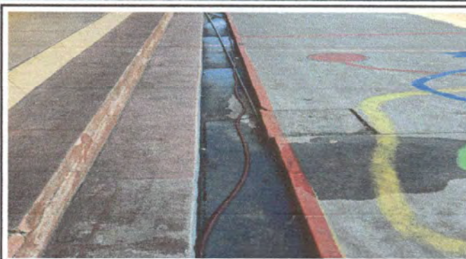
Reparación de red de agua potable
