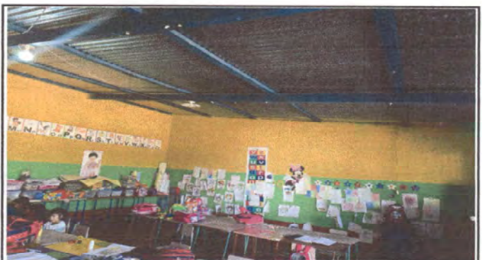
Reparación eléctrica en aula
