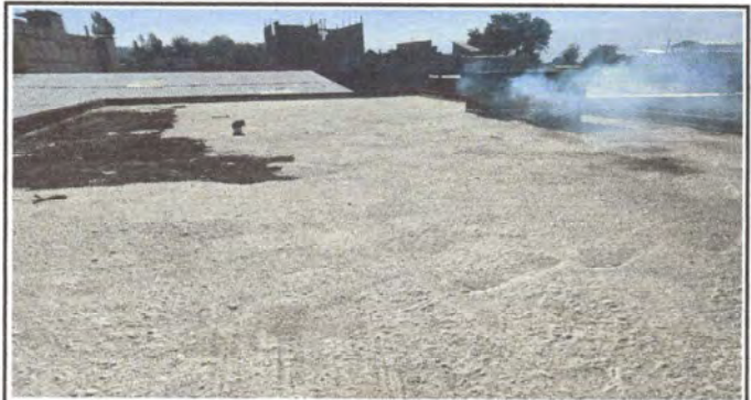
Impermeabilización de losa de cocina
