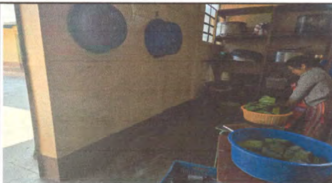
Instalación Mesón de concreto azulejado
