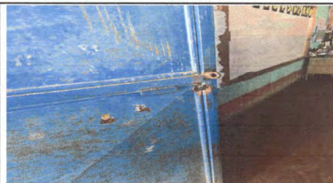
Mantenimiento de puerta y cambio de chapa
