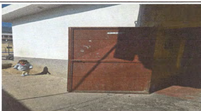
Mantenimiento de puerta y cambio de chapa
