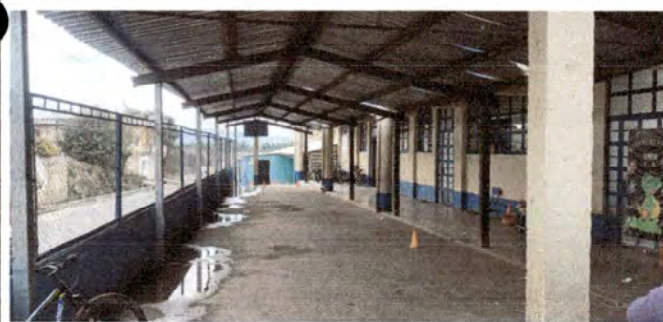
Foto 5: Mantenimiento de estructura de soporte de metal.
