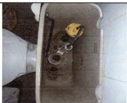
Foto 11: Sustitución de accesorios de inodoro (4 inodoros)+sustitución de 1 inodoro
