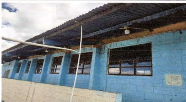
Foto 9: Sellado de abertura entre techo de lamina y solera de concreto 72mts lineales*0.3mts de altura.
