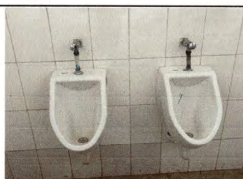
Foto 12: Sustitución de accesorios de 3 mingitorios
