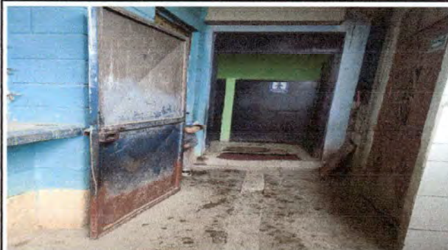
Foto 8: Sustitución de puerta (Cambio de ubicación de puerta, incluye sellado de espacio con muro de block de 2.60mts*1.50mts+apertura de vano para reinstalación de puerta.
