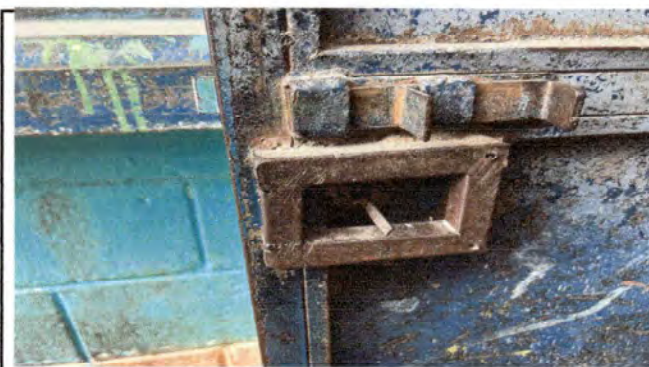
Foto 10: Sustitución de 5 chapas marca Yale
