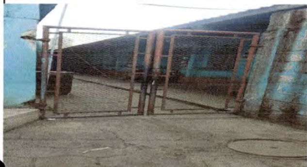
Foto 7: Fabricación e instalación de portón de metal de ingreso de 1.56mts*1.95mts incluye chapa marca Yale
