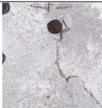
Foto 3: Reparación de la bajada de agua, del segundo nivel para el primero y así evitar que el agua se repose en la terraza.
