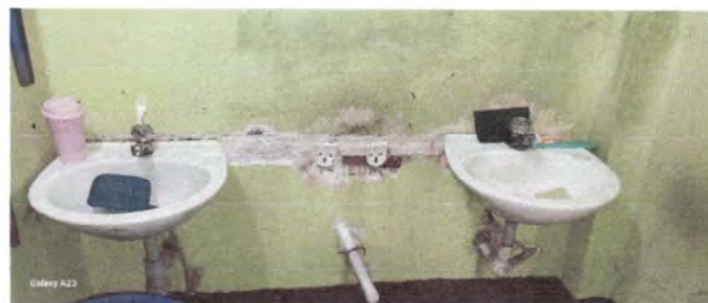
Foto 4: Sustitución de sanitarios, lavamanos, sus accesorios y colocación de azulejos en las paredes, tanto de hombres como mujeres.
