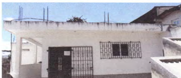
Foto 1: Reparación de techo metálico para evitar la caída de aguas pluviales y la entrada del agua al salón de computación.
