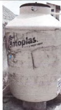
Foto 7: Sustitución de deposito de agua y accesorios para que pueda surtir en la cocina.
