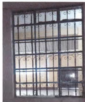
Foto 2: Reparación de ventanas corredizas para la ventilación de las aulas.
