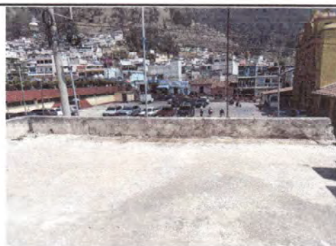
Foto 6: Continuación de muro perimetral, para evitar el peligro que implica que los estudiantes se paren en la orilla del segundo nivel.
