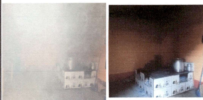
Foto1: En la cocina hay mucho humo, por el diseño de la plancha no puede sacar el humo en la chimenea.
