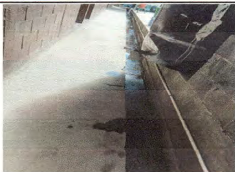
Foto 1: Reparar la sanja del patio, por reposadera de agua.
