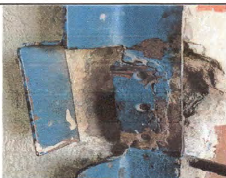
Foto 3: Cambio de chapas y un lado del marco de puerta de metal, de tres aulas, realizando el mismo trabajo en cada aula, por deterioro y tiempo de uso.
