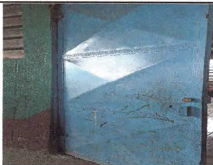
Foto1: Aula sustitucion de puerta de metal por metal
