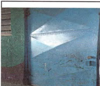
Foto 4: Aula sustitucion de puerta de metal por metal
