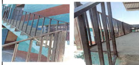
Foto. 6 Mantenimiento de baranda con aplicación de pintura anticorrosiva a dos manos y soldadura del segundo nivel
