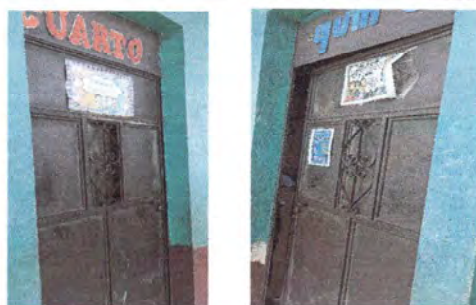
Foto 6: Mantenimiento de puertas con pinturas
