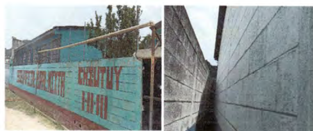
Foto 4: Pintura de paredes de exteriores de 8 aulas
