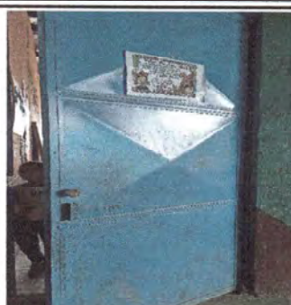
Foto 2: Aula sustitucion de puerta de metal por metal
