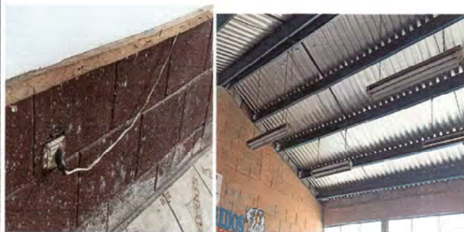
Foto 5: Instalaciones electricas en todas las 9 aulas
