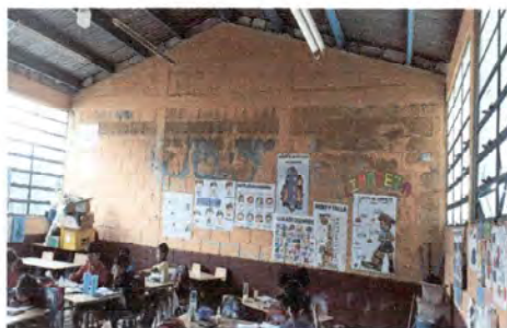
Foto 3: Pintura de paredes interiores de 8 aulas
