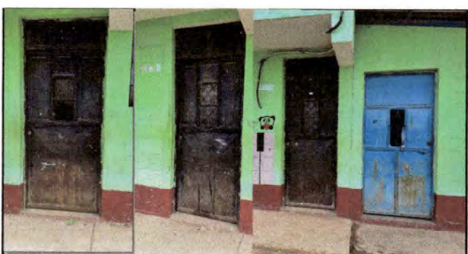
Foto 5: Mantenimiento de puertas de metal, incluye pintura y ajuste en tamaño por instalación de piso ceramico
