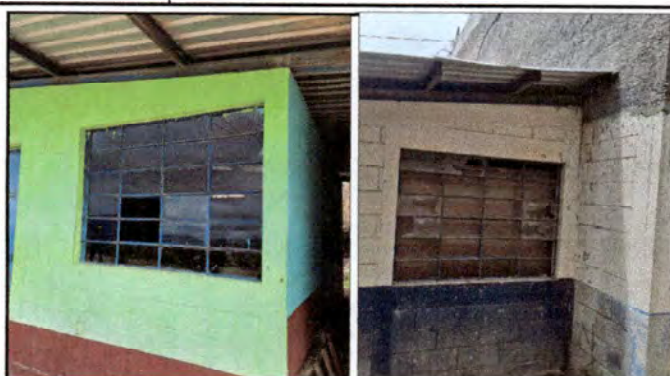
Foto 2: Instalación de balcon en cocina 1.6 m * 1.2 m, instalación de vidrios para ventanas 0.4m * 0.2 m, incluye desmontaje y sellado con cilon
