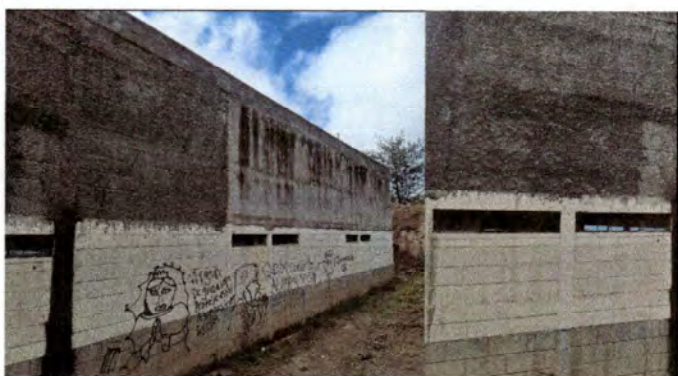
Foto 3: Instalación de balcones traseros en aulas y cocina 1.33 m * 0.26 m
