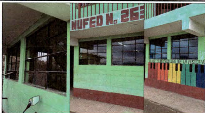
Foto 1: Instalación de balcones de 1.34 m * 1.02 m en salones
