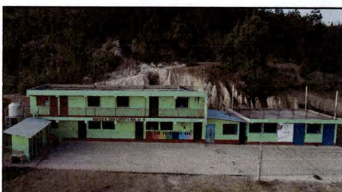
Foto 4: Pintura latex libre de plomo y mercurio en fachada principal
