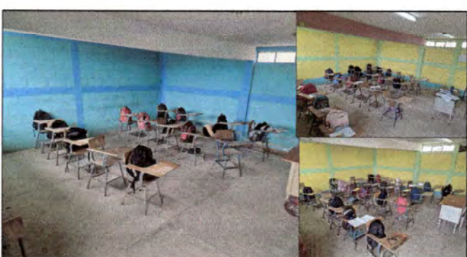
Foto 6: Instalación de piso ceramico sobre piso de concreto, en 3 aulas y pintura de para el interior de los salones de clases.
