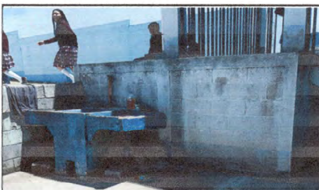
Foto 4: Sustitución de 1 pila de cemento de 2 lavaderos y instalacion de 1 pila de cemento
