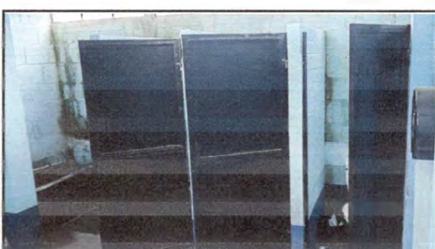
Foto 6: Sustitución de 4 lavamanos con accesorios, y sustitución de accesorios de 4 sanitarios instalacion de 3 mingitorios
