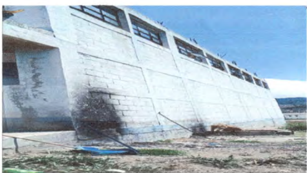
Foto 5: Suministro de Impermiabilización en Muro exterior del Establecimiento
