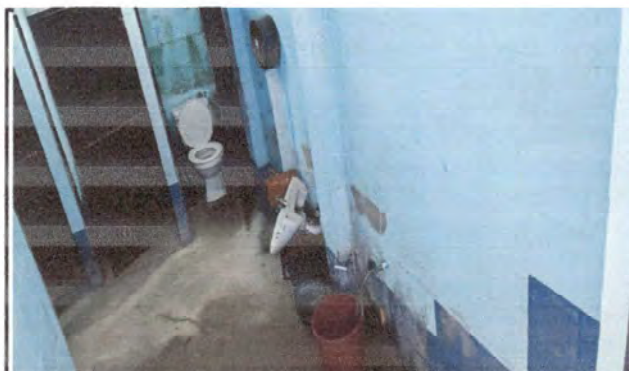
Foto 3: Sustitucion de 4 lavamanos con accesorios, sustitución de accesorios de 4 sanitarios y instalación de 3 mingitorios
