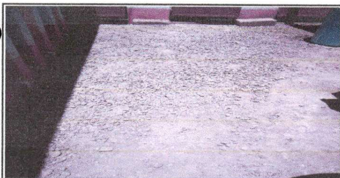
Vista de será intervenido cambio de red de agua potable y remozamiento del piso de sanitarios
