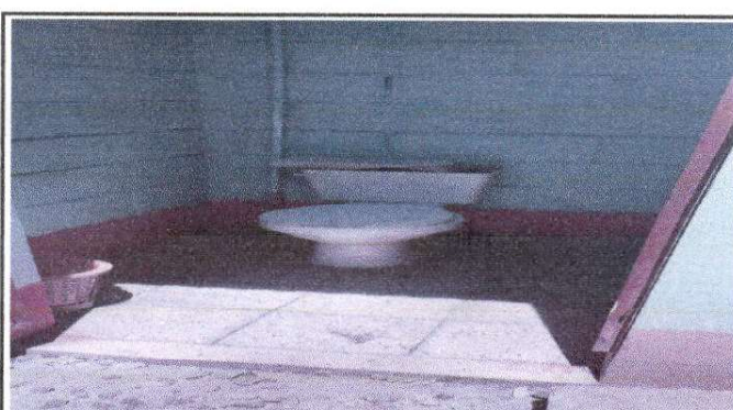
Vista Frontal de cambio de sanitarios, accesorios y pintura
