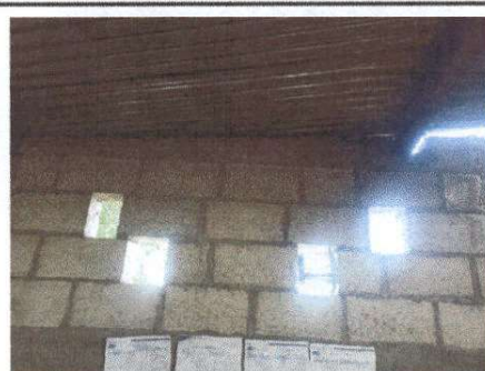
Foto 8: Abertura de ventana y colocacion de ventana para tener buena iluminacion
