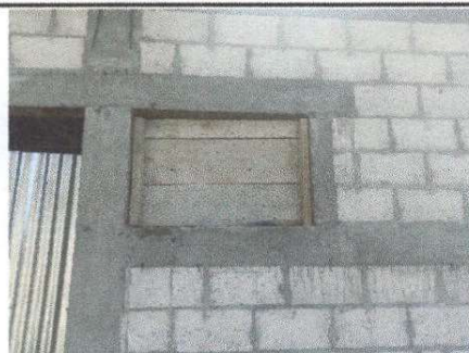
Foto 7: cambio de ventana por una de upvc para tener una cosina presentada
