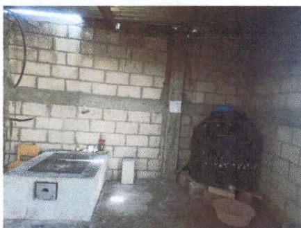
Foto 3: Repello interno y externo del area de cosina
