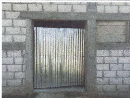
Foto 5: puerta de doble hoja fabricada de metal pues la que tiene es de lamina y esta insegura la cosina.
