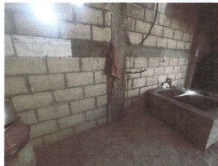
Foto 2: En esta area se construira la mesa de trabajo para la preparacion de los alimentos.
