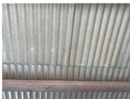
Foto 10: cambio de techo ya que las laminas estan picadas e incompletas por aire.
