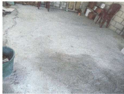
Foto 4: nivelacion de contrapiso en instalacion de piso ceramico.
