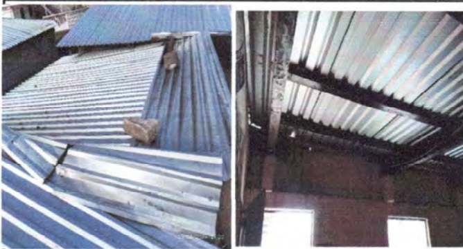
Foto 1: Vista de techo de dirección que será cambiada en su estructura y cubierta.
