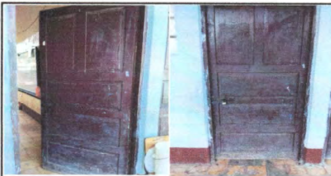
Foto 5: Vista de puerta donde será instalada chapa para puerta.
