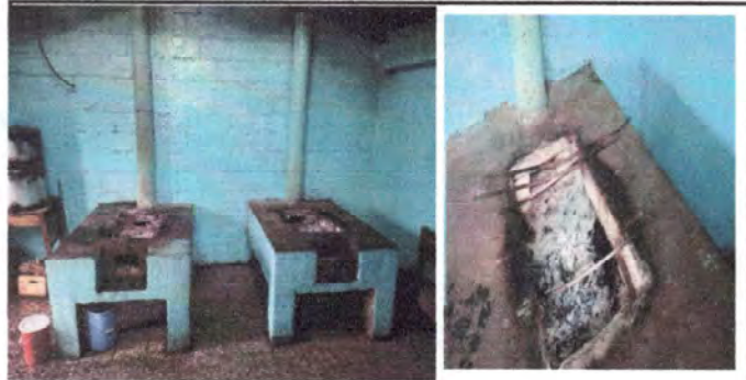
Foto 2: Vista de cocina y estufas de leña donde se hará la sustitución de estufas de leña e instalación de piso.
