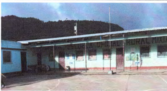
Foto 3: Vista de salones donde serán sustituidas puertas.
