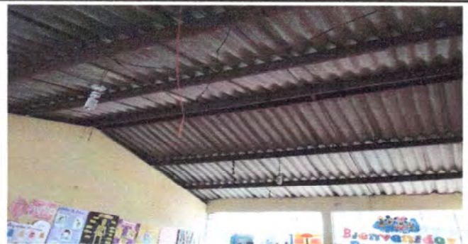
Foto 4: Vista de aulas donde serán cambiadas y mejoradas instalaciones eléctricas
