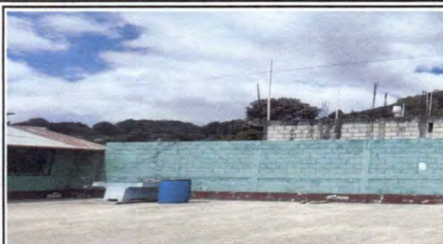
Foto 1: Vista y area de cocina a intervenir pila de concreto mas drenaje
