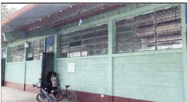
Foto 3: Vista frontal de las ventas a sustituir y colocación de balcones
