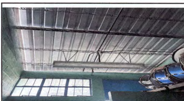
Foto 4: Vista frontal de la reparación del sistema electrico
