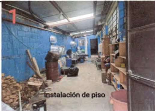
Foto 1: sustitución de piso torta de cemento a piso antideslizante
