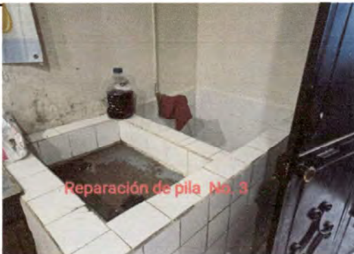
Foto 3: Reparación de pila existente
