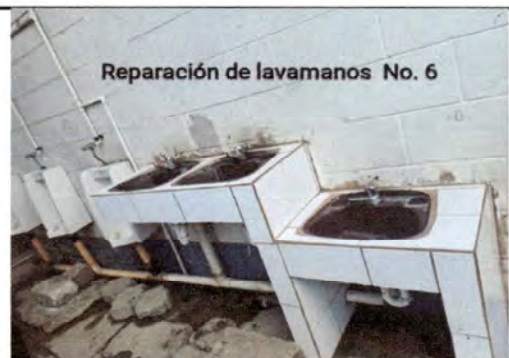
Foto 6: Reparación de mingitorios y lavamanos existentes
