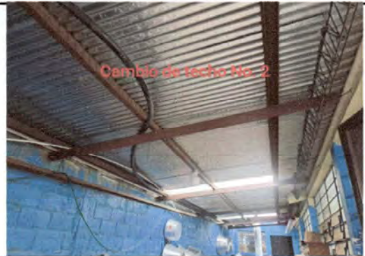
Foto 2: Cambio de techo lamina existente por lamina troquelada.
