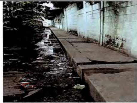
Foto 2: Instalación de caja trampa de grasa para la acumulación de aguas grises eliminando foco de contaminación alrededor del establecimiento.
