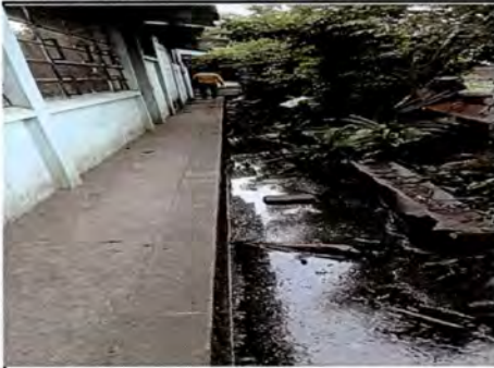
Foto 1: Mantenimiento de desagüe del establecimiento por acumulación de aguas grises.
