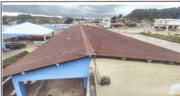
Foto 7: Fotografía del techo del modulo 3
