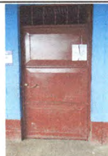
Foto 8: Puerta a darle mantenimiento aula 1
