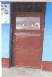
Foto 9: Puerta a darle mantenimiento aula 2
