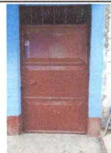
Foto 10: Puerta a darle mantenimiento aula 3
