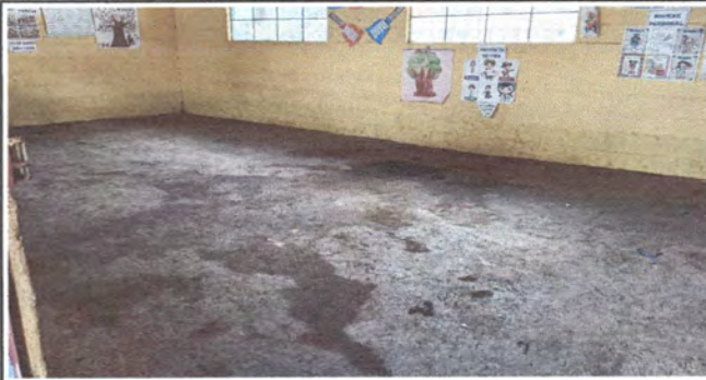
Foto1: Fotografía de piso del aula 1
