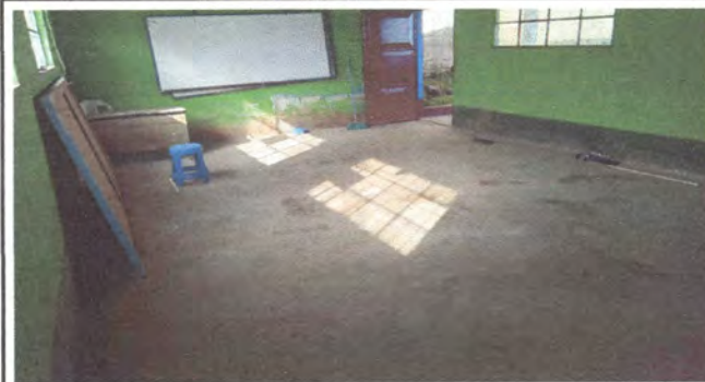
Foto 3: Fotografía de piso del aula 3
