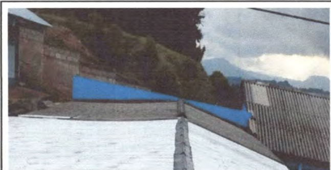
Foto 6: Techo del modulo 2
