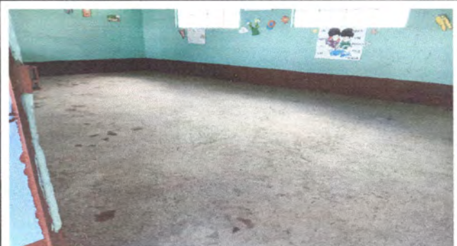
Foto 2: Fotografía de piso del aula 2
