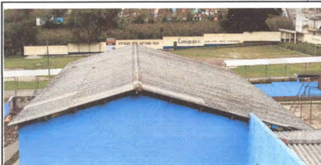
Foto 5: Techo del modulo 1
