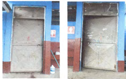
Foto 12: Fotografía de las puertas a darle mantenimiento de baños
