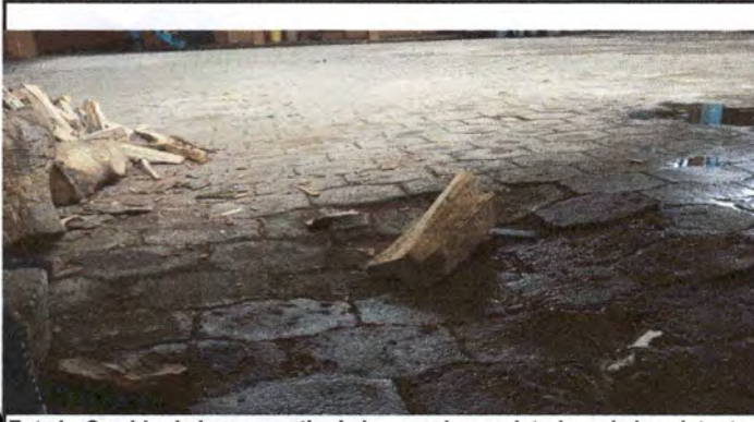
Foto 1: Cambio de loza en patio de la escuela por deterioro de la existente.
