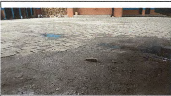
Foto 3: Sustitución de tubos de drenaje.
