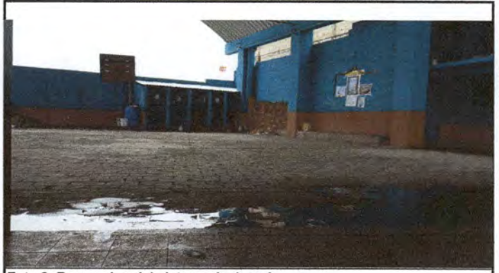
Foto 2: Reparación del sistema de drenaje.
