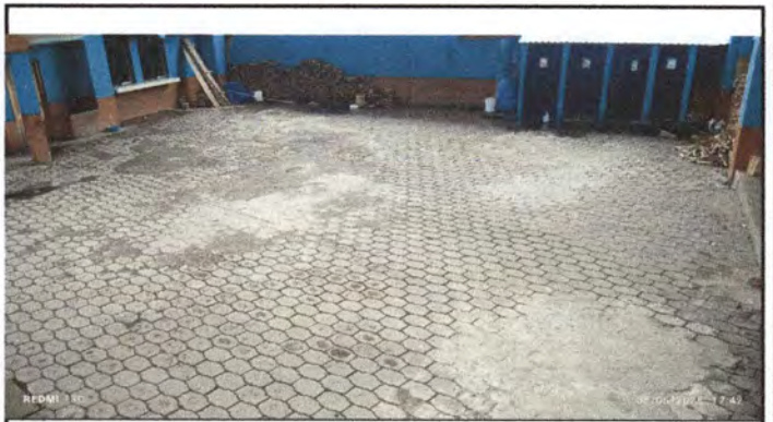
Foto 4: Sustitución de adoquines deteriorados por nuevos.
