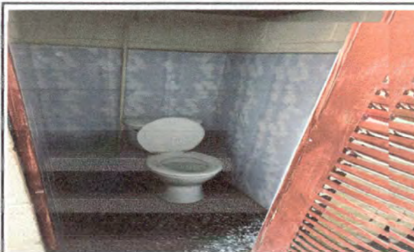
Foto 2: Cambio de dos inodoros en el baño de niñas y dos inodoros en baño de niños
