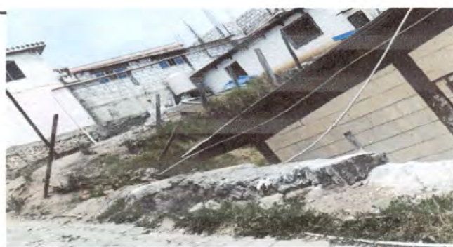
Foto 5: Reparación de circulación de escuela.
