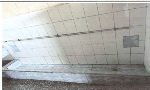
Foto1: Demolición de mingitorios por nuevos mingitorios, Reposición de piso de granito de mármol en área de nuevos mingitorios. Incluye extracción de rípio y material de desperdicio
