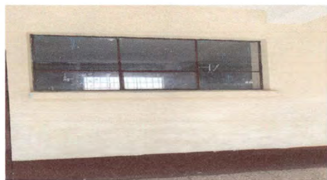
foto 10: colocación de 2 balcones
