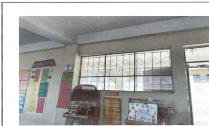
Foto 9: Cambio de 6 ventanas de metal por pvc
