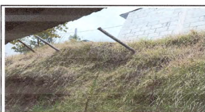
Foto 6: Reparación de circulación de escuela.
