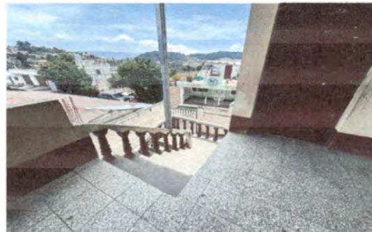
Foto 4: Fabricación de barandas de protección.
