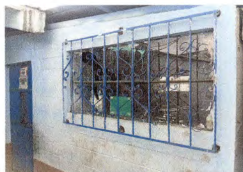
Foto 4: Desmontaje e instalación de ventanas de PVC de aulas, módulo C del edificio escolar y reparación eléctrica.
