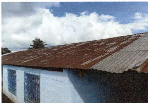
Foto1: Techo de aulas para desmontaje e instalación de láminas troqueladas calibre 26, módulo B del edificio escolar reparación eléctrico.
