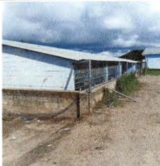
Foto 5: Vista lateral del muro perimetral de la escuela
