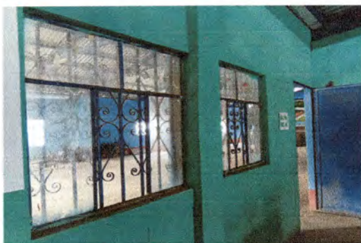
Foto 3: Desmontaje e instalación de ventanas de PVC de aulas, módulo A del edificio escolar.
