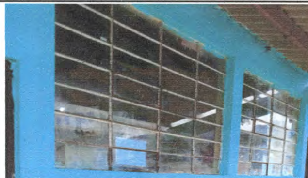
Foto 4: Mantenimiento de estructura de 4 ventanas
