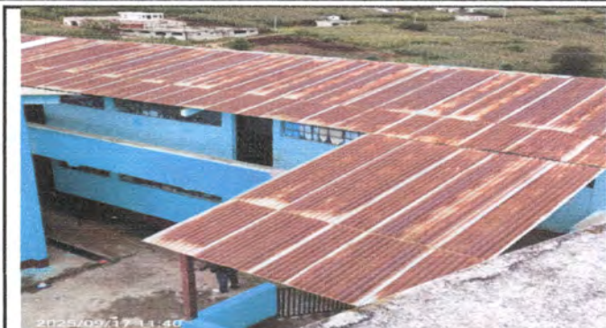
Foto 1: Módulo 1 Segundo nivel 3 aulas 200 metros.
