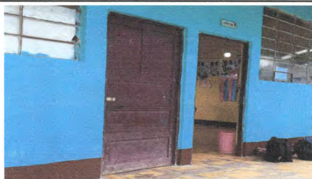
Foto 3: Sustitucion de puerta de madera
