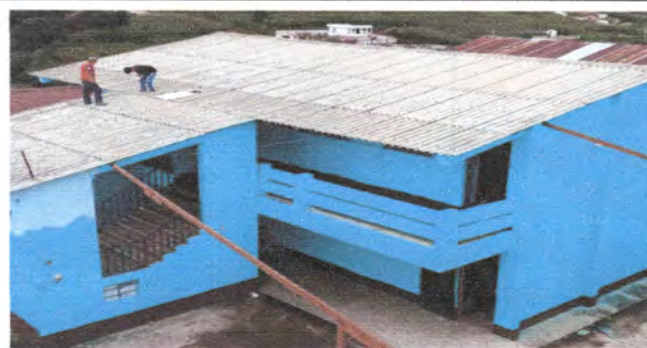
Foto 2: Módulo 2 segundo nivel 2 aulas 255.60 metros
