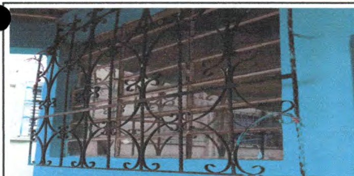
Foto 5: Cambio de ventana
