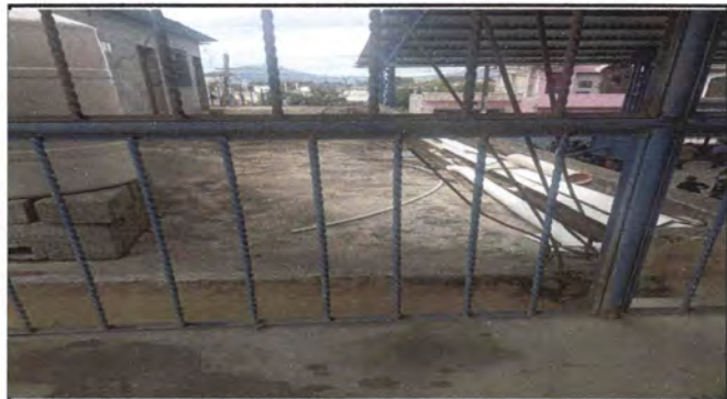
Foto 10: vista de colocación de rampa
