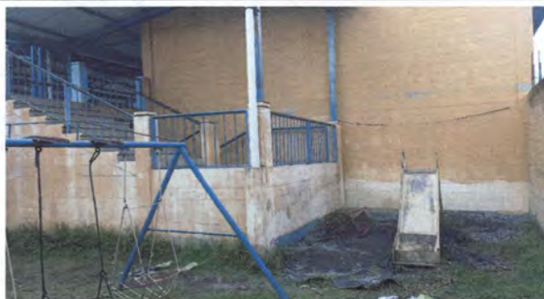
Foto 1: Vista area de pintura
