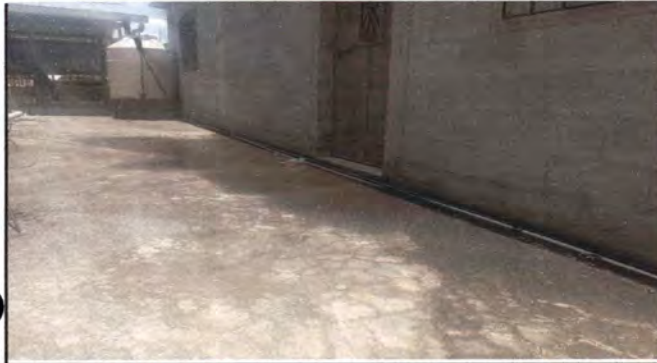
Foto7: Vista area de impermeabilización de losa
