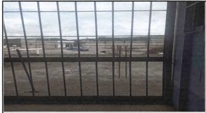
Foto 8: Vista de colocación de puerta 1
