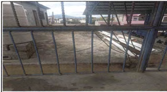
Foto 9: vista de colocación de puerta 2
