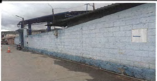
Foto 5: Vista de fachada
