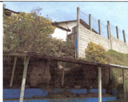
Foto 6: Complemento de muro perimetral 2.50 mt.
