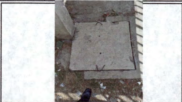
Foto 8: Reparación de planchan de concreto de aguas negras.
