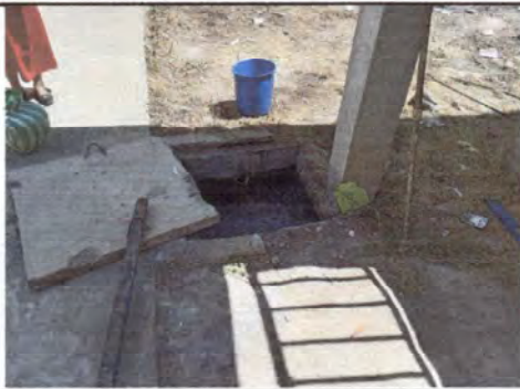
Foto 1: Sustrucción de tubería de aguas negras.
