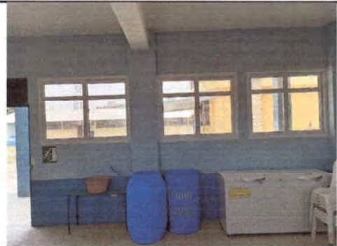
Foto 4: Fabricación de balcones para bodega de cocina.
