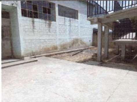
Foto 3: Sustrucción de piso de tierra por adoquín.
