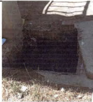
Foto 2: Mantenimiento de caja de aguas negras.
