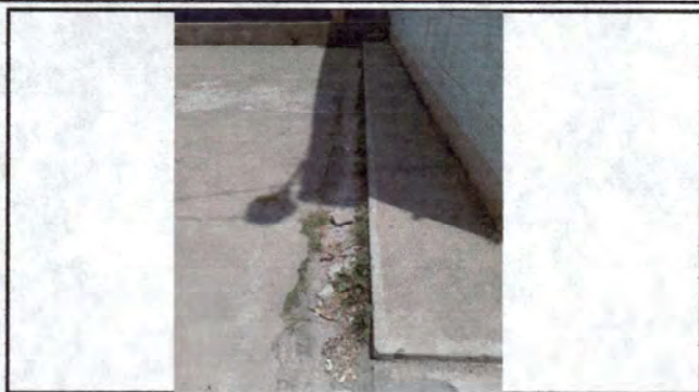
Foto7: Reparación de cuneta.
