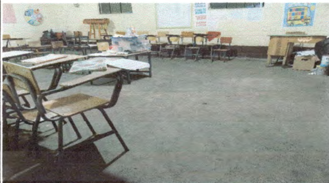
Foto 3: Cambio de piso en un aula y corredor
