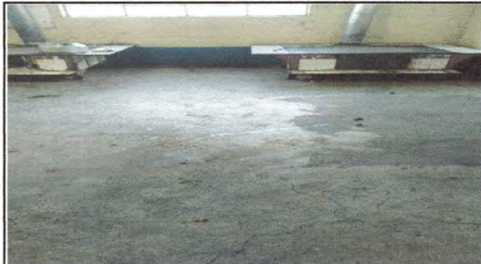
Foto 2: sustitución de piso concreto a cerámico en la cocina
