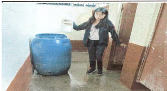
Foto1: Remodelación de baño
