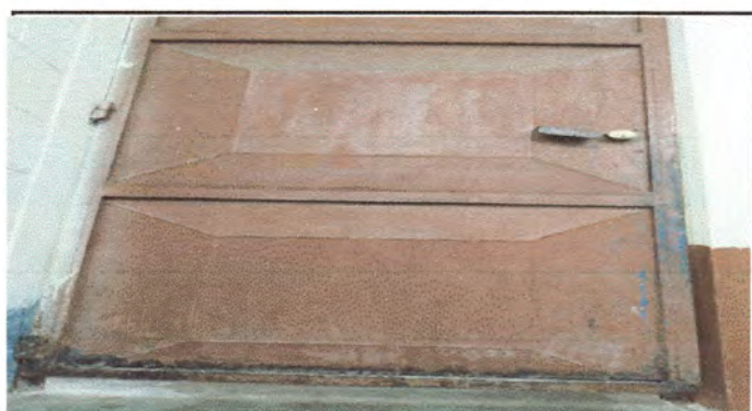
Foto 4: Reparación de puertas.
