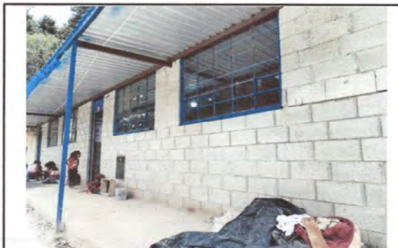
Foto 3: Parte externa de ambas aulas, donde se visualiza que no hay repello.
