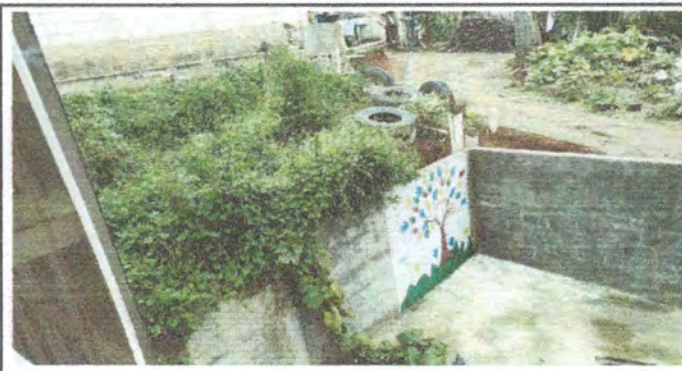
Foto 2: Cuneta: colocación de 12 metros de drenaje frances y 12 metros de cuneta para contener las aguas pluviales y que encuentren una salida adecuada que no perjudique las instalaciones del instituto
