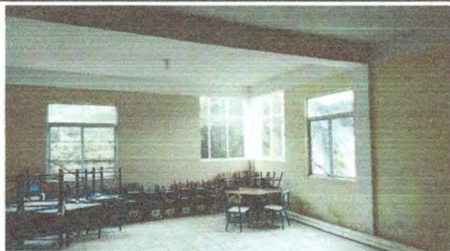
Foto 3: Instalar 31 balcones o rejas de seguridad para las ventanas de 3 aulas, 2 bodegas, 4 baños, 1 en las gradas y 1 en dirección
