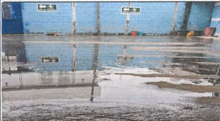
Foto 1: Mantenimiento y cambio de tubería de bajada de agua pluvial, que en época lluvia se desborda en el patio.
