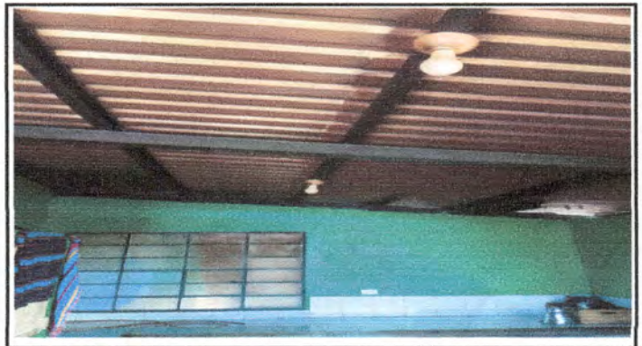
Foto 4: Cambio de pintura
