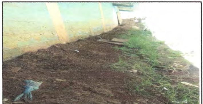
Foto 6: Arreglo de cuneta detras de las aulas
