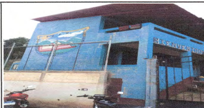
Foto 5: cambio de pintura externa
