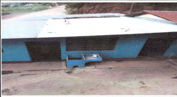
Foto1: Cambio de ventana. de metal a pvc
