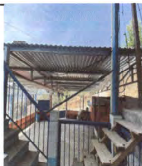
Foto 8: Mantenimiento de estructura metálica te techo y sustitución de gradas de madera por gradas de metal.
