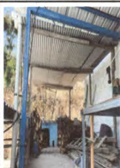
Foto 8: Mantenimiento de estructura metálica te techo y sustitución de gradas de madera por gradas de metal.
