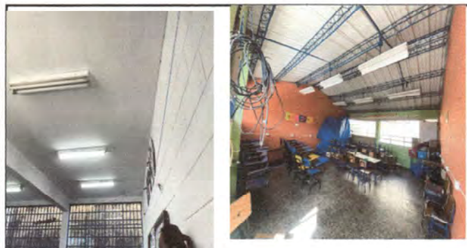
Foto 3: Mantenimiento del Sistema Eléctrico
