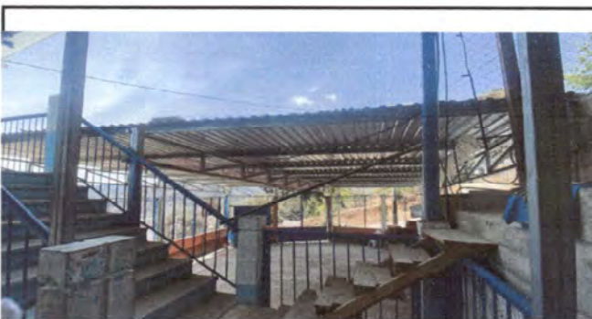
Foto 4: Mantenimiento e instalación de barandas
