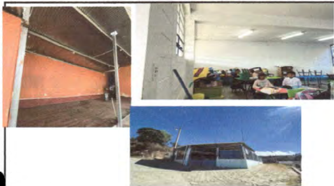
Foto1: 1. Pintura de Muros Interiores y Exteriores.
