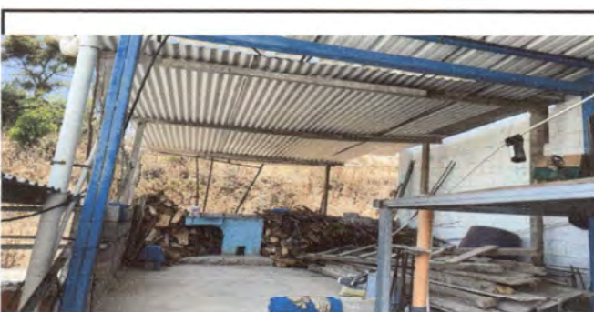
Foto 6: Sustitución de laminas en techo.
