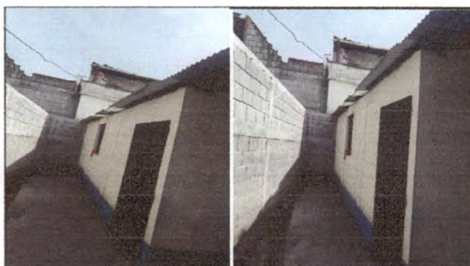
Foto 4: Sustitucion de lamina por lamina calibre 26
