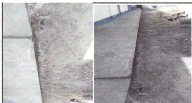
Foto 6: Sustitucion de tubería PVC línea principal agua pluviales 4.
