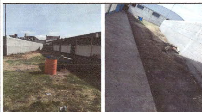
Foto 3: Sustitucion de piso con adoquin de trafico liviano decorativo.
