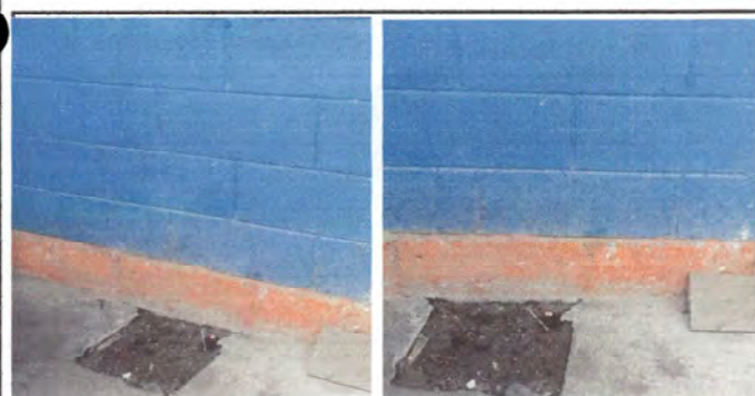
Foto 5: Reparacion de cocina lavatrastos.
