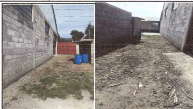
Foto 2: Sustitucion de piso de concreto.
