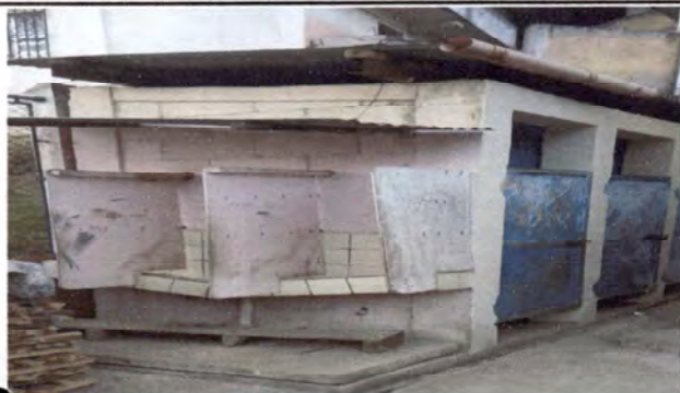
Foto 7: Sustrucción e instalación de mamparas para mingitorios
