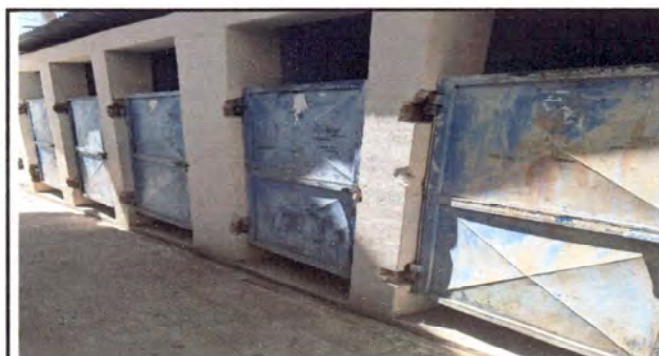
Foto 6: Reparación de puertas de baño y pintado.
