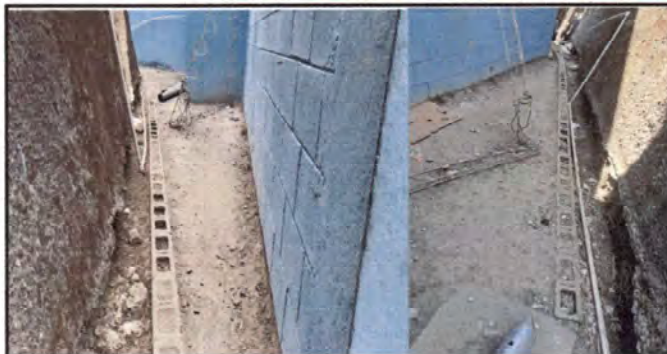
Foto 2: Reparación de acera área posterior de escuela con fundición para tráfico liviano.
