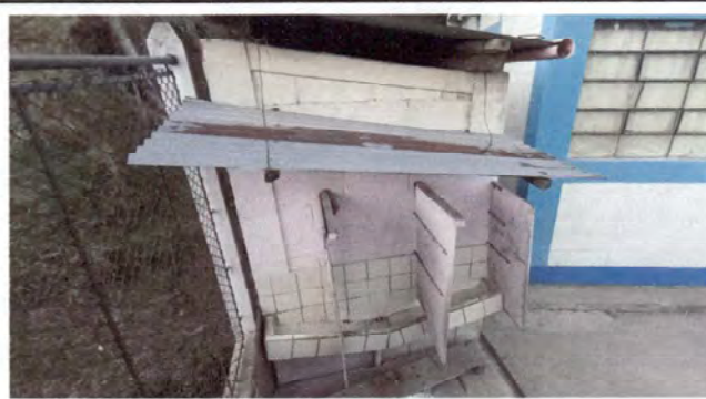
Foto 8: Sustrucción de entechado sobre mingitorio.
