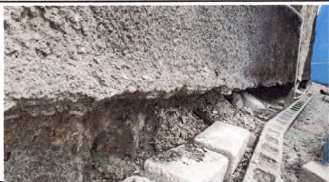
Foto 1: Reparación de muro de contención con inyección de concreto.
