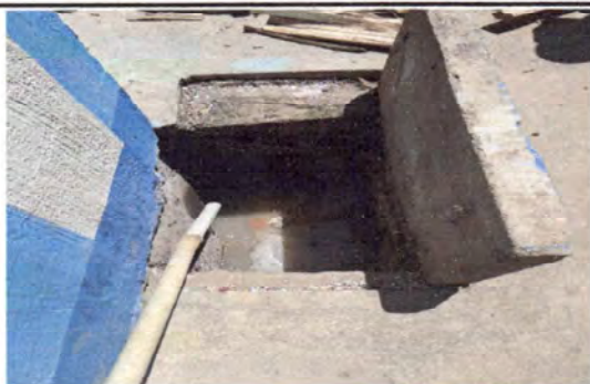
Foto 5: Reparación de drenaje en cocina, reparación de pila existente, elaboración de caja trampa de grasa.
