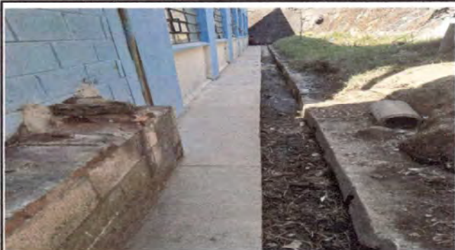
Foto 3: Reparación de cuneta de concreto parte posterior de la escuela.
