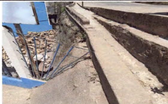
Foto 4: Reparación de bordillo entrada lateral de la escuela.
