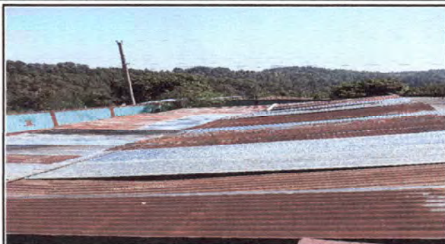
Foto 1: Vista de la cubierta de techo del patio, en frente de las aulas, se removerá con estructura y cubierta de techo de lamina.
