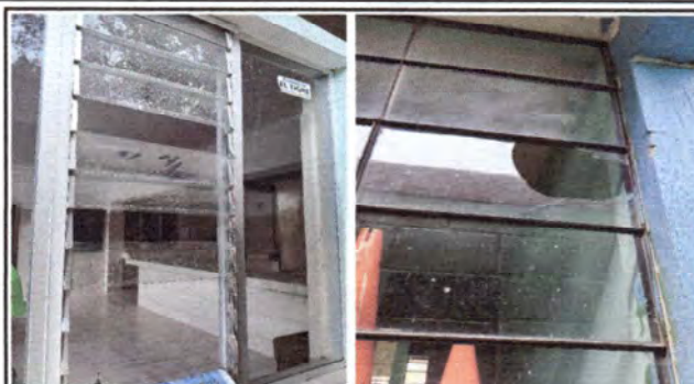
Foto 2: Vista de las ventanas de aulas y cocina a sustituir.
