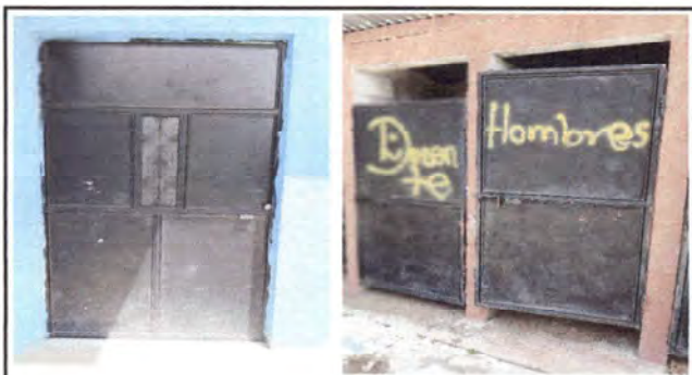
Foto 3: Vista de mantenimiento de puertas de baños, aulas y cocina.
