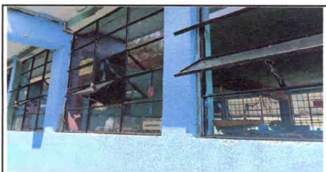
Foto 5: Vista de ventas de aulas, que no cuenta con balcones.
