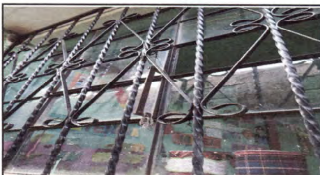
Foto 4: Vista de mantenimiento de balcones de las aulas.
