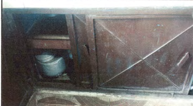
Foto 2: Sustitución de puertas de metal
