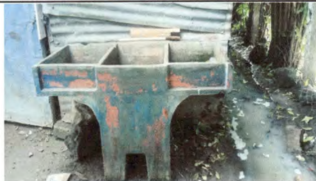
Foto7: Sustitución de pila
