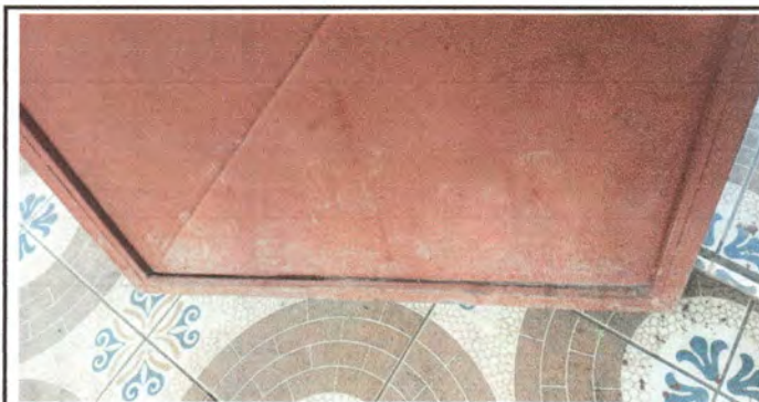
Foto 5: Mantenimiento de puertas
