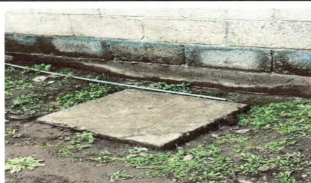
Foto 8: Sustitución de tuberías de aguas negras
