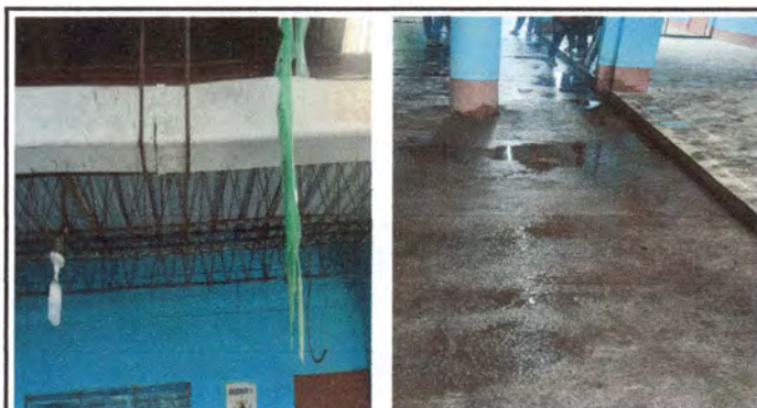
Foto 3: Sustitución de canales de agua pluvial
