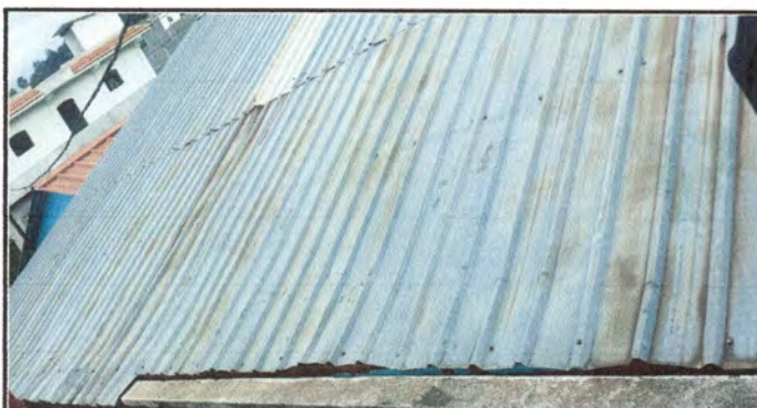
Foto 4: Sustitución de láminas
