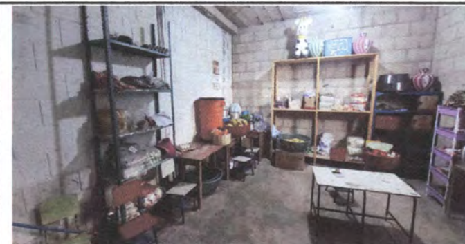
Foto 4: Reparacion de repello y cernido de paredes en la bodega de alimentos y colocación de piso lavable.
