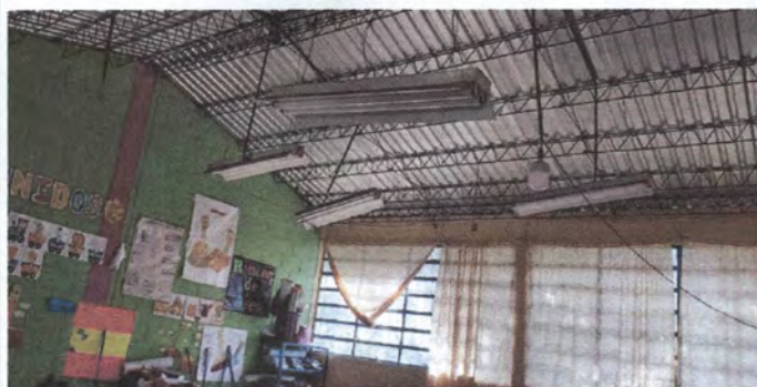
Foto1: Reparacion de Sistema Electrico
