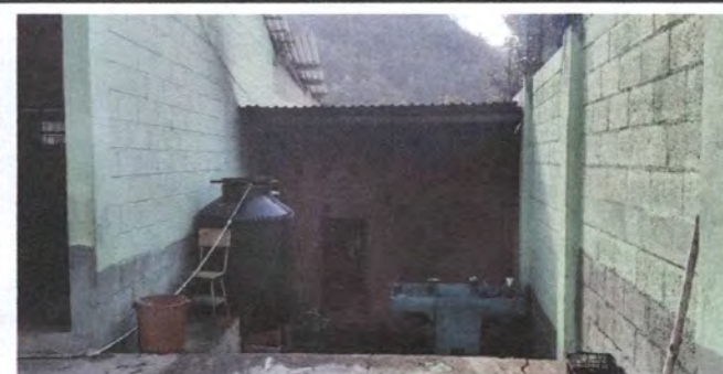
Foto 6: Reparacion de cocina, mejoramiento de pila
