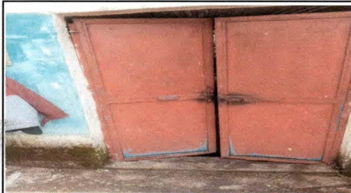
Foto 3: mantenimiento a puertas de baño y aulas del establecimiento, porton principal, bodega, dirección
