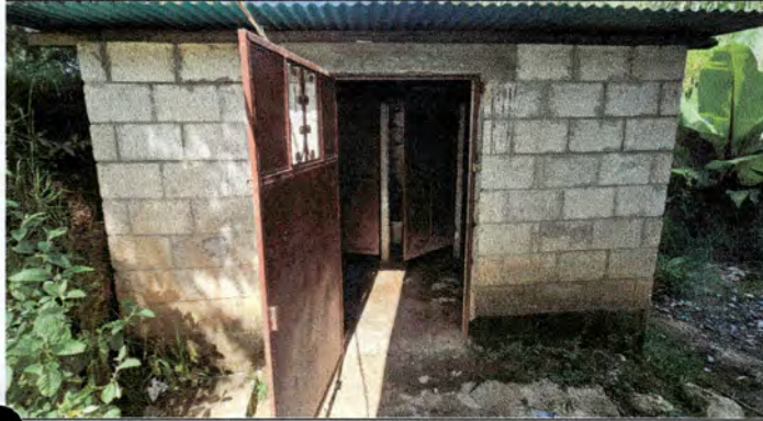
Foto 1: repello y cernido de paredes de baños interno y externa mente, sustitución de lamina.
