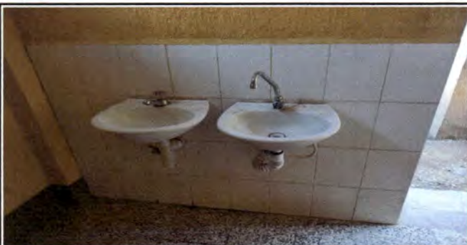
Foto 11 Sustitución de lavamanos
