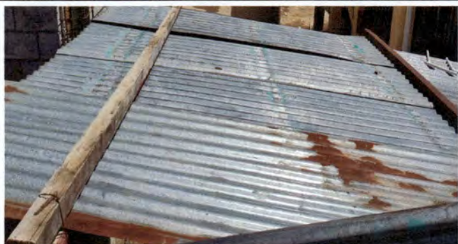
Foto 1: Sustitucion de cubierta de lamina, 2. Estructura de techo, 4. Canales y bajadas de agua pluvial.
