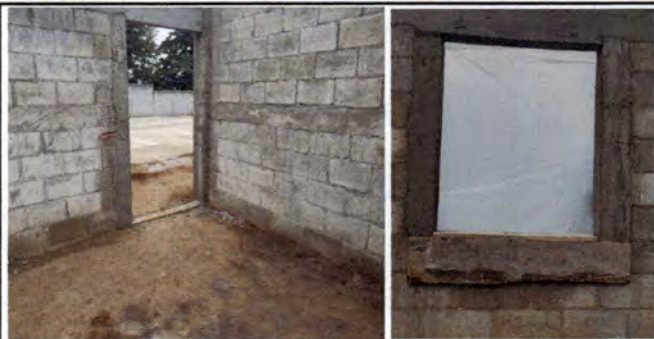
Foto 9: Fabricación e Instalación de Ventanas y Puerta de Metal
