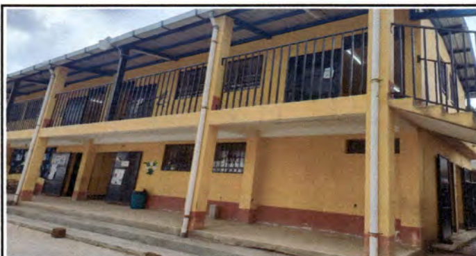
Foto 5. Pintura en Interiores y Exteriores
