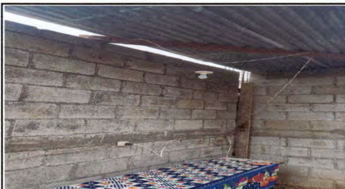
Foto 6: Reparación de Sistema Eléctrico
