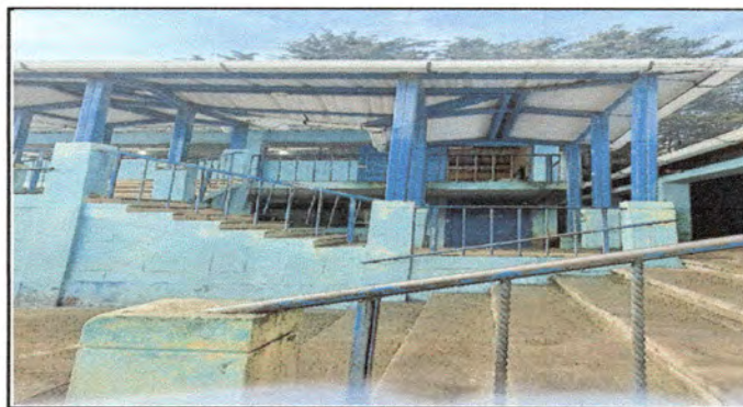
Foto 6: Pintada de estructura y barandas con las medidas 32 mts de largos x 1 mt de alto.
