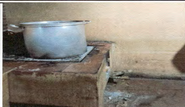
Foto 1: Fabricación de 1 plancha de cocina, con acabado de azulejo.
