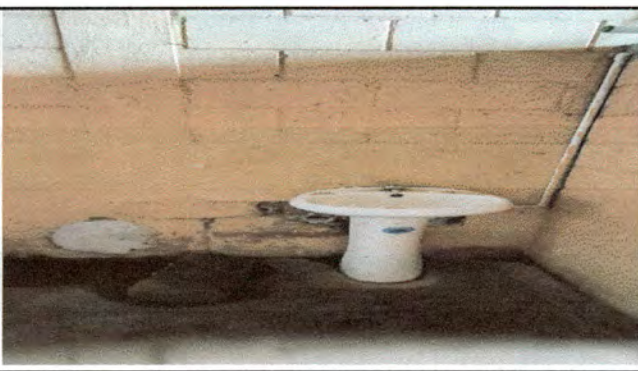
Foto 5: Colocación de azulejo en el área de baños, pared y suelo, 54 mts.
