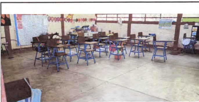
Foto 3: Cambio de piso en Aula No. 3
