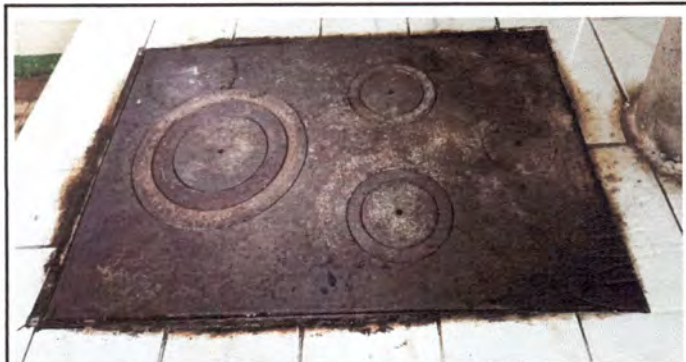
Foto 5: Sustitucion de plancha de metal de cocina
