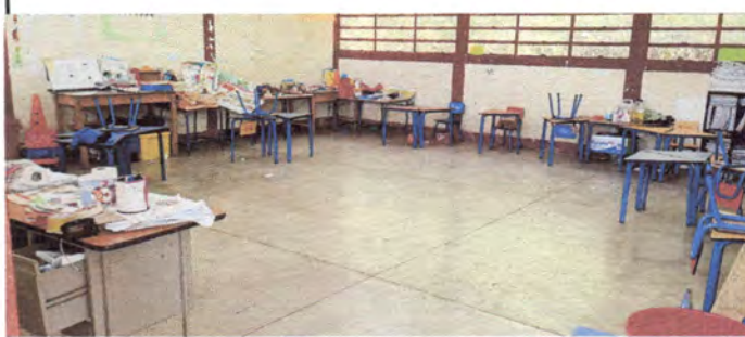
Foto 2: Cambio de piso en aula No. 2
