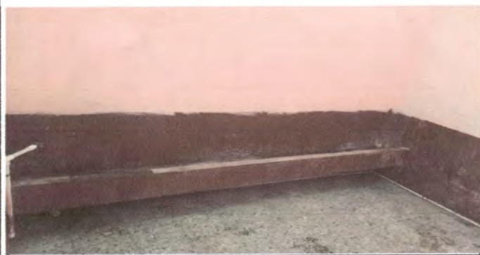
Foto 5: DEMOLICIÓN DE MIGITORIO Y COLOCACIÓN EN LOZA
