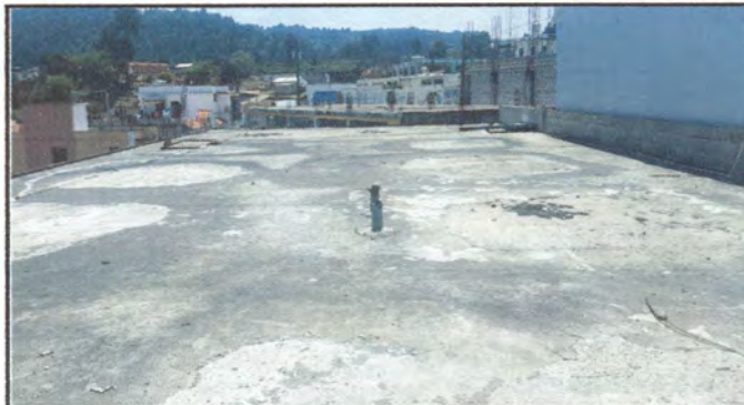
Foto 2: IMPERMIABILIZACIÓN DE TERRAZA
