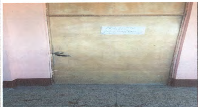
Foto 3: SUSTITUCION DE UNA PUERTA DE MADERA POR UNA DE METAL QUE SE ENCUENTRA EN EL PASILLO
