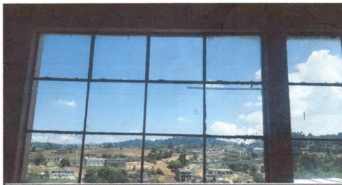
Foto 6: COLOCAION DE VIDRIOS EN VENTANAS
