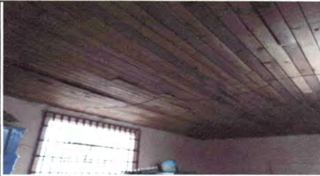
Foto 1: cambio de machimbre en mal estado en interior de 3 aulas y corredor exterior
