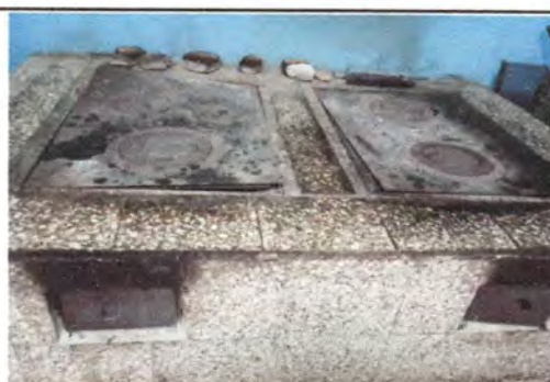
Foto 14: suministro, cambio e instalación de dos planchas de metal para estufa de leña en cocina
