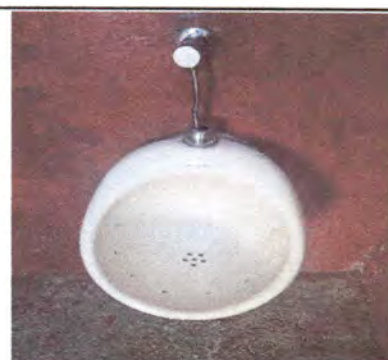
Foto 8: Mantenimiento y ajuste de orinal en baño incluye limpieza de tubería reposición de accesorios y ductos de salida
