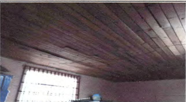
Foto 3: Desmontaje de machimbre, ajuste, limpieza y colocación del mismo machimbre en techo interior de 3 aulas
