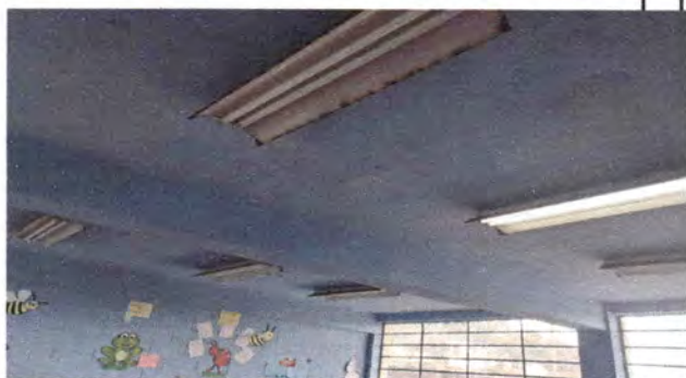
Foto 11: cambio de focos por tubos led de 18w de plastico mas calbeado y accesorios electricos en 3 aulas
