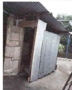
Foto 4: Sustitución e instalación de lamina troquelada para techo de bodega exterior
