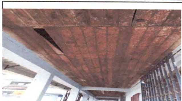
Foto 2: Cambio de machimbre en mal estado por machimbre nuevo en el interior del techo de 3 aulas y corredor exterior
