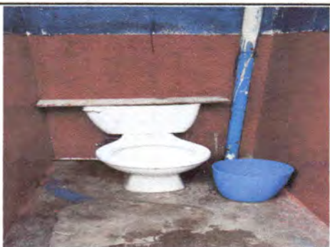
Foto 7: Suministro cambio e instalación de inodoro de porcelanato color blanco en baños exteriores, incluye accesorios
