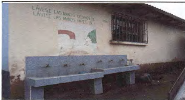
Foto13: suministro y aplicación de pintura en pared exterior de aulas mas impermeabilizante en zocalo a una altura de 1.00 mts
