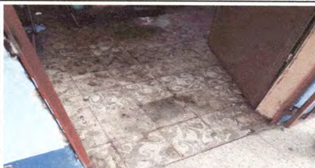
Foto 10: instalación de piso cerámico en dirección y sala de reuniones de profesores
