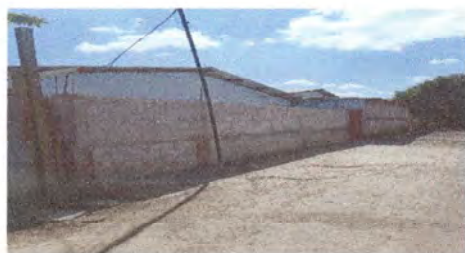
Foto 3: Reparación de muro perimetral de 2 hiladas de block.
